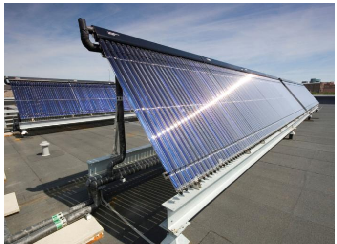
Ilustración 4: Captador de tubos de vacío
