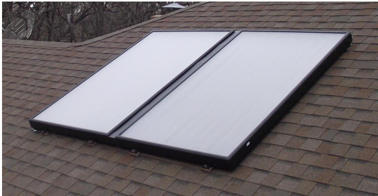
Ilustración 3: Captador placa plana
